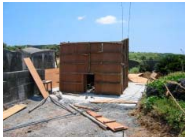
コンクリートの土台に 2 重の木枠を立て、そこに生コンを流し込む仕組み。その中には鉄筋を入れる。
