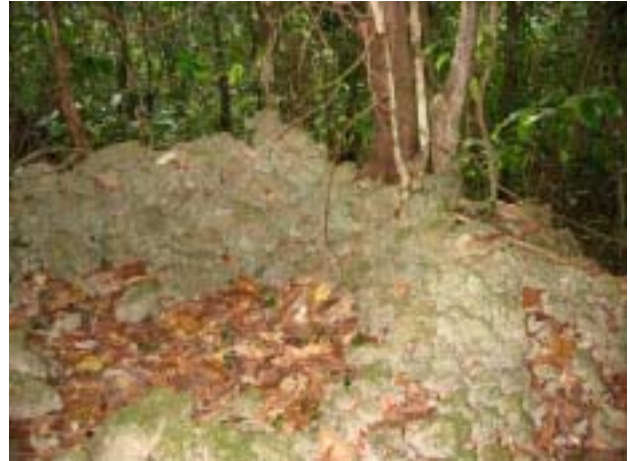
ごつごつとした石灰石を積み上げて作ってあった。隆起珊瑚礁のこの島では、土嚢を作ることは難しかったらしい。
