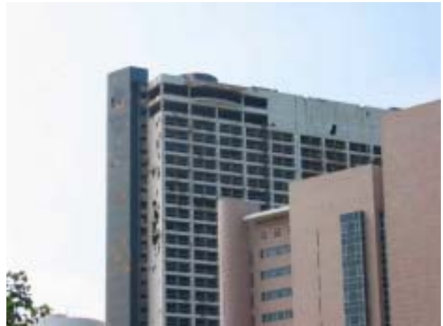
内戦で穴だらけになったビル。高層だけに簡単に壊したり修復できないせいか未だに残っている。
