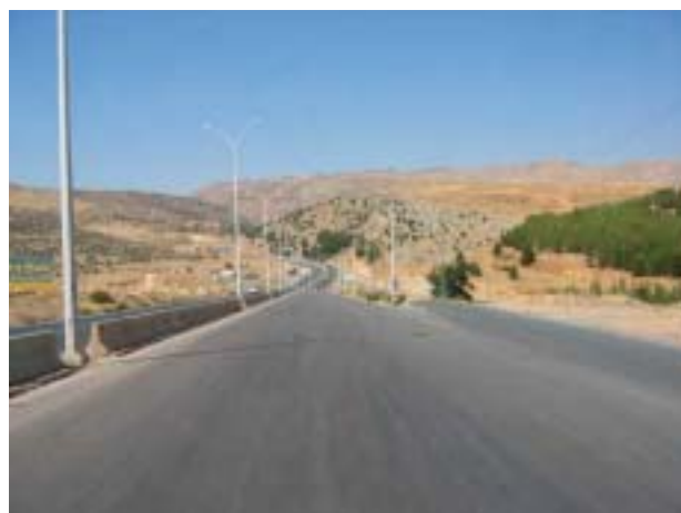
乾燥した大地に、きれいにひかれていたアスファルト道路。車線は書いてないが、3 車線分くらいはあってぶっ飛ばせる。
