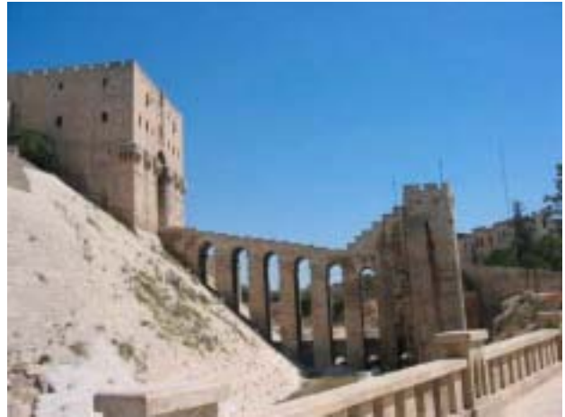
アレッポ城の22メートルの深さのお堀に掛かった橋。周囲は2.5キロメートル。
