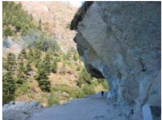
山の中腹の道。崖をくりぬく形で道路を通しているところもある。道路脇には崩れた石も多く、結構怖い。
